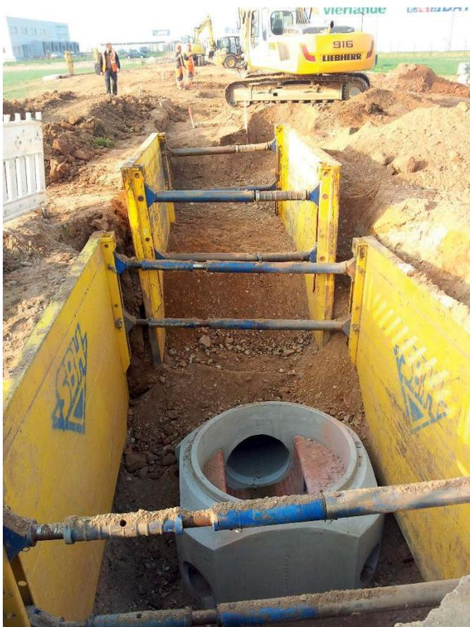
**Bild:** Kanalbaumaßnahme mit Verbau zur Erschließung von Gewerbegrundstücken
